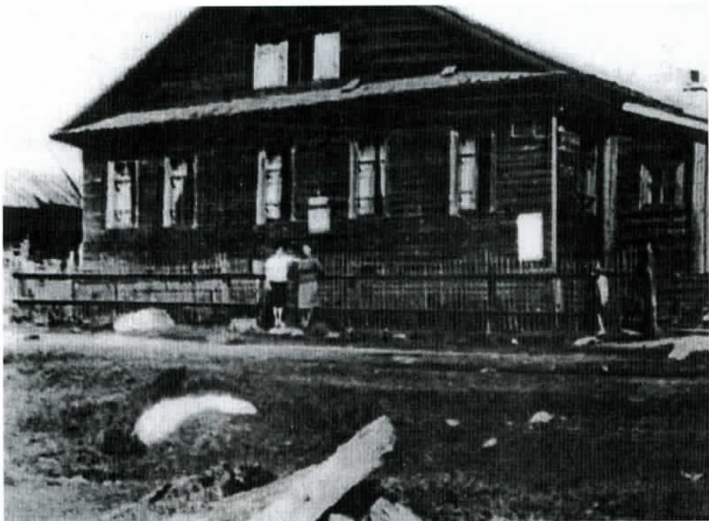
Kevättämäjärven ensimmäinen koulutalo, joka valmistui v. 1905. Koulu toimi tässä vuoteen 1941. Sotien jälkeen siihen siirrettiin klubi ja kylään rakennettiin uusi koulutalo, mutta koulu lakkautettiin jo 1960-luvulla.
